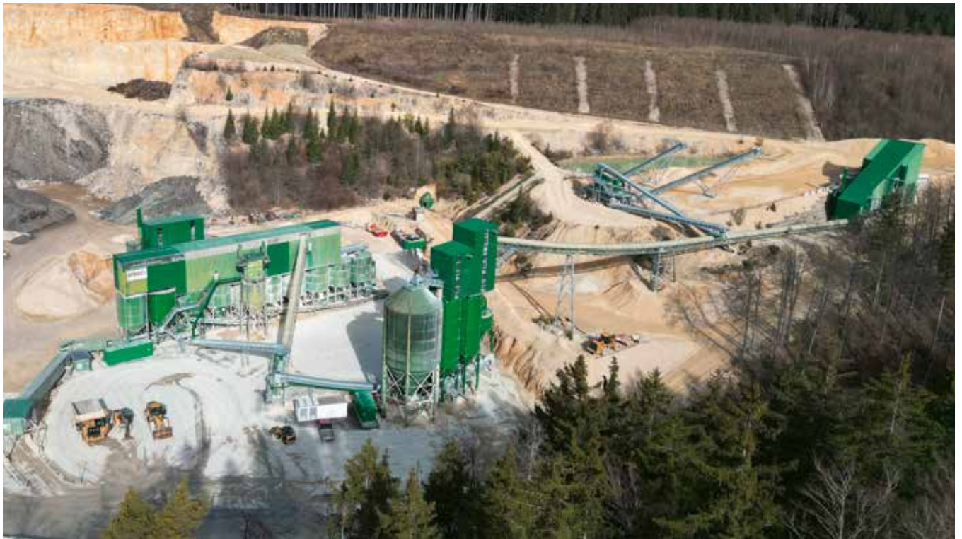
DAS MODERNISIERTE SCHOTTERWERK IN NEUHAUSEN OB ECK: rechts auf der Anhöhe die Vorbrechanlage, in der Mitte die drei Puffersilos, links die Siebstraße. Fotos: Storz/Beck/Kesselstatt
