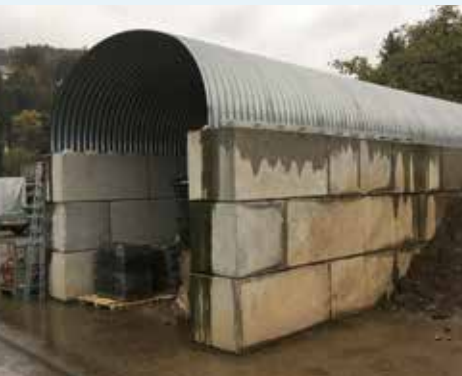
Preiswerte Überdachung von Schüttgut- boxen mit Achenbach-Hauben
