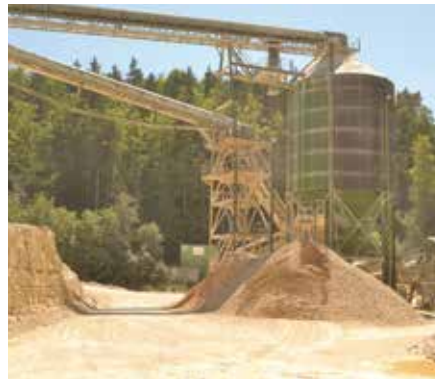
DIREKTER VERGLEICH: Vor der Modernisierung stand nur das große Puffersilo (l.) zur Verfügung, nun werden die unterschiedlichen Korngrößen in drei Puffersilos zwischengelagert.
