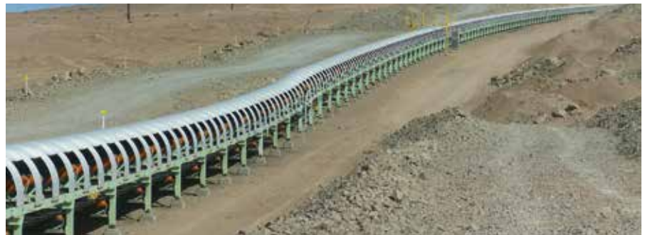
17 km langer Haubentunnel in Peru aus einer Kombination von schmalen AFlex-Bügeln und einseitig offenen Sichthauben
