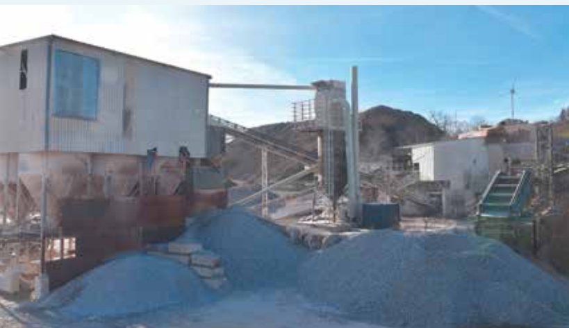
KURZE WEGE: Die kompakte Anlage ist fast komplett eingehaust und verrät ihre Leistungstärke nicht auf den ersten Blick.
